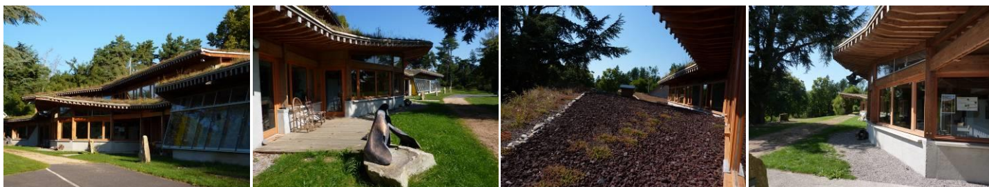
Vues du bâtiment HQE (Haute Qualité Environnementale)
